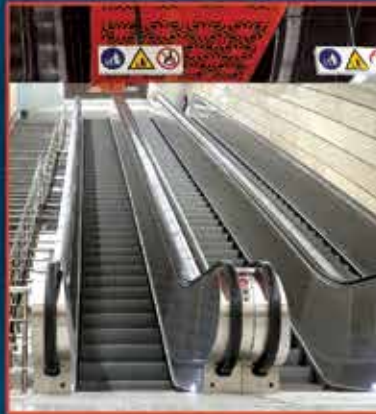
مترو خط ۶ و ۷ ۱۸۵ پله برقی ۱۲۰ آسانسور
